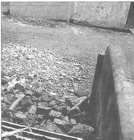
Fleißig saniert wird schon der ehemalige Forsthof. Der Innenausbau ist schon voll im Gange, wie der Schutthaufen belegt.
